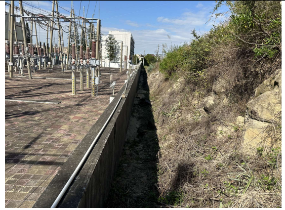
东园 110kV 变电站东北侧现状
