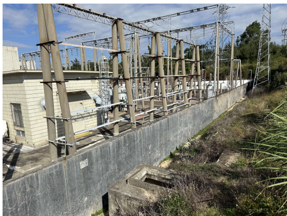
东园110kV变电站东南侧现状
