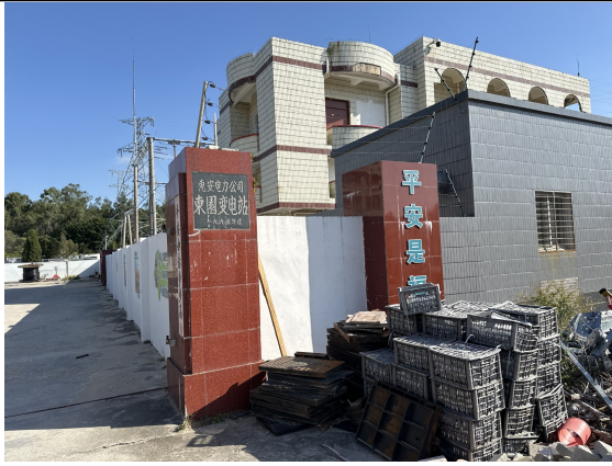
东园 110kV 变电站西北侧现状
